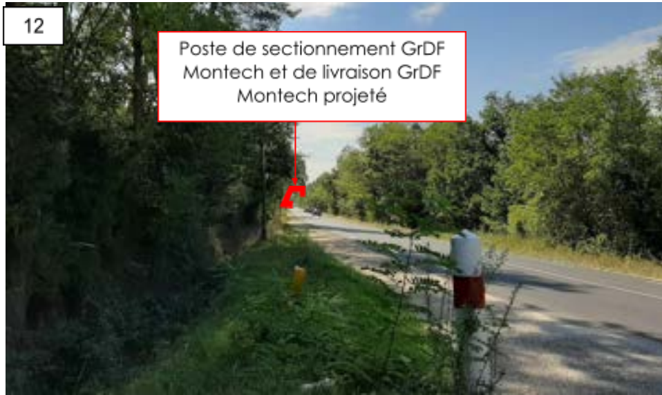
Photographie 4 : Vue du futur poste de sectionnement depuis le point 12
