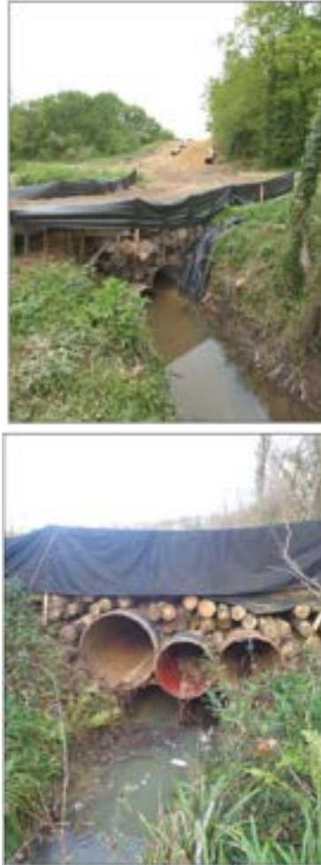
Figure 7. Gaines métalliques recouvertes d'un platelage en rondins de bois (photo : TEREGA)
