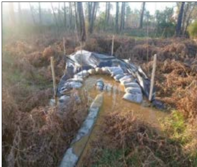
Figure 56. Exemple de bassin d'infiltration (source : TEREGA)
