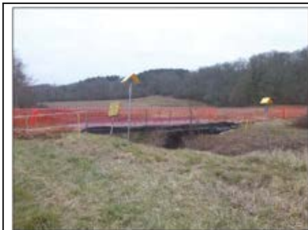
Figure 8. Pont composé d'un assemblage de plusieurs structures métalliques (Source : chantier Artère du Béarn)
