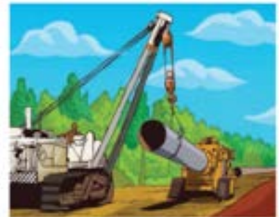
Cintrage sur site pour épouser le profil du terrain
