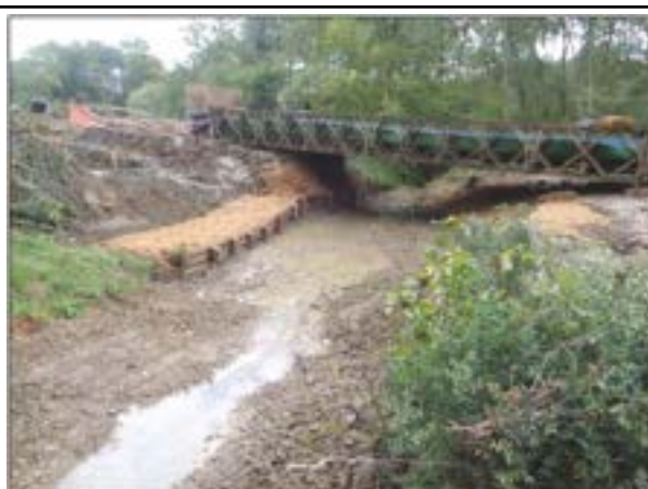
Figure 9. Pont du génie civil/pont Bailey (Source : Chantier Artère de l'Adour)
