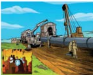
Soudage des tubes et revêtement des joints
